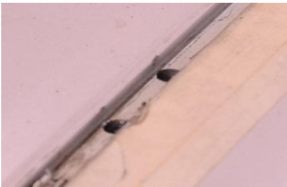
4. Наносим герметик (мы брали шовный) на пластины **позиция 1,2**, на плоскость которая будет прилегать к крыше, чтобы в дальнейшем избежать протечки крыши
